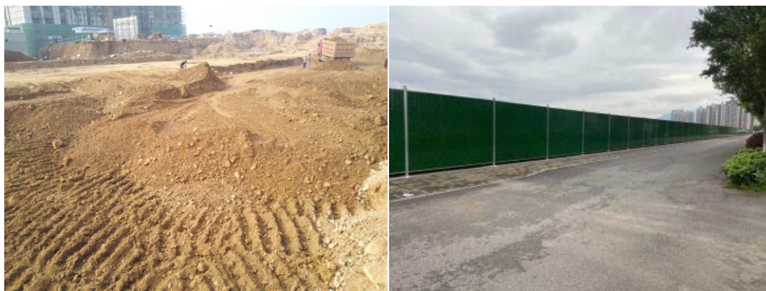
2017 年表土剥离、临时拦挡
