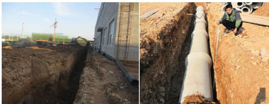
2018 年雨水管网管沟开挖及管网铺设
