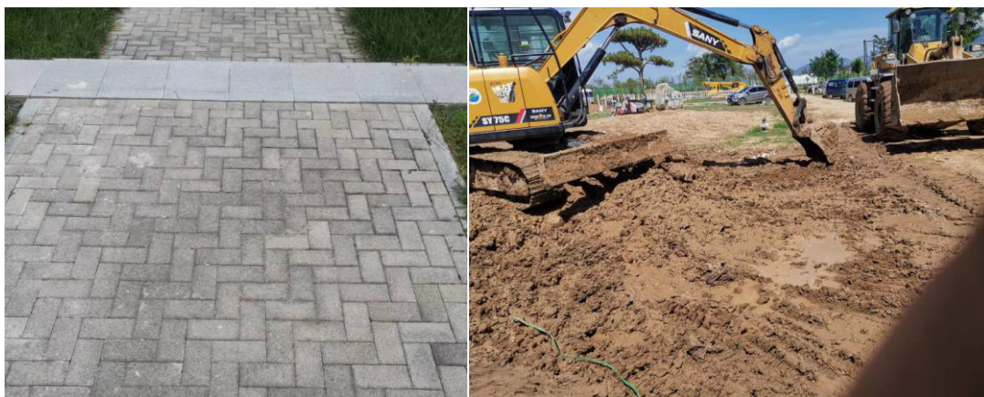
2018 年铺设透水砖、土地平整
